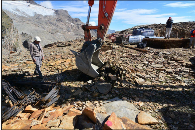
Scavo con pala meccanica
