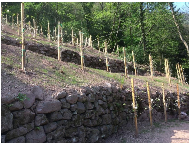
Fig. 2.11: muretti a secco a scopo di terrazzamento e impianto di giovani piante di melo (archivio azienda, 2020).
