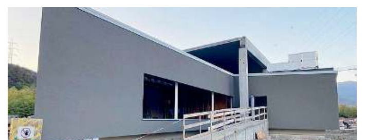
L'impianto. Il nuovo depuratore di Valle Trompia, a Concesio
