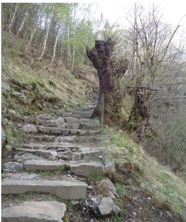
Figura 5: Tratto di mulattiera, con gradini in granito San Fedelino
