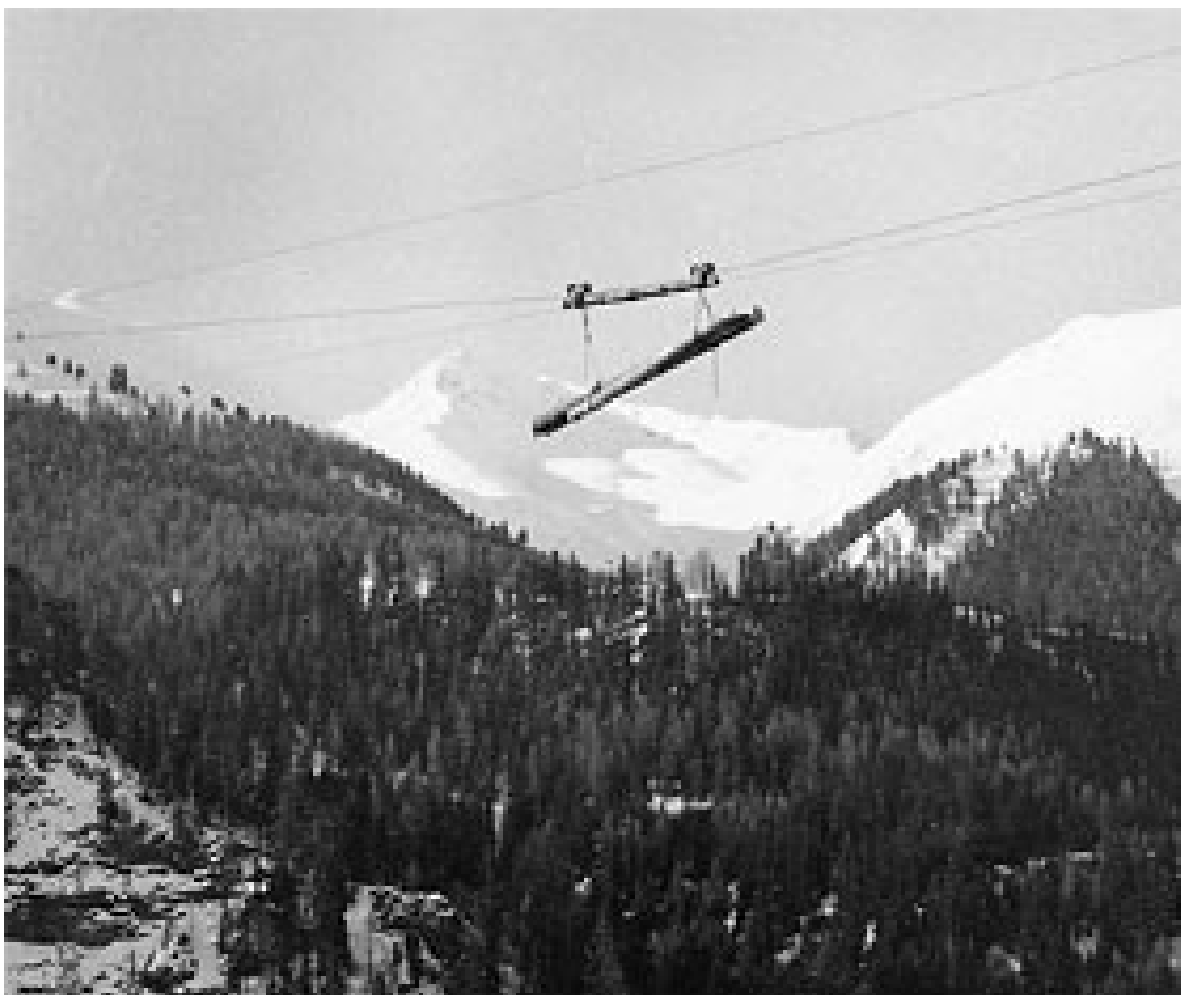
Figura 18 Esempio di teleferica tipo Valtellina (tratta dal sito www. waldwissen.net )
