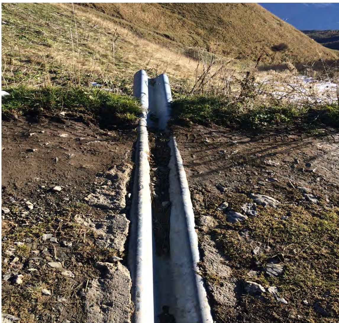
Figura 11: Le canalette di scolo
