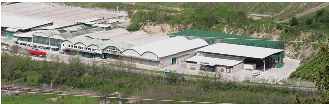
Figura 2 - Cooperativa di Ponte in Valtellina
