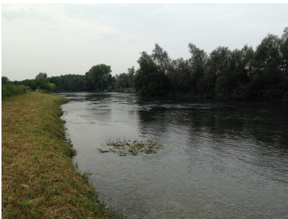
Figura 5: Argine di contenimento situato in prossimità di Massimbona
