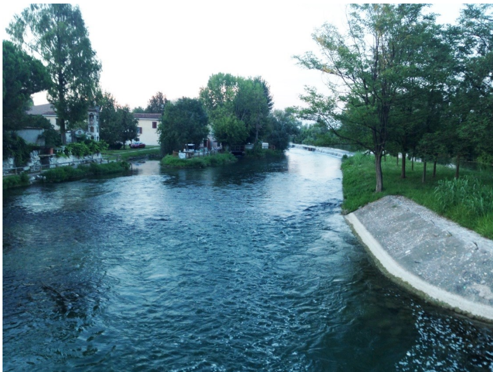
Figura 4: Particolare di sostegno spondale in calcestruzzo situato tra il ponte Calatrava e il ponte stradale
