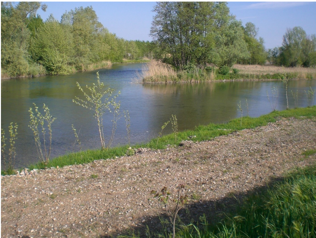
Figura 11: due immagini che rappresentano la situazione immediatamente dopo i lavori
