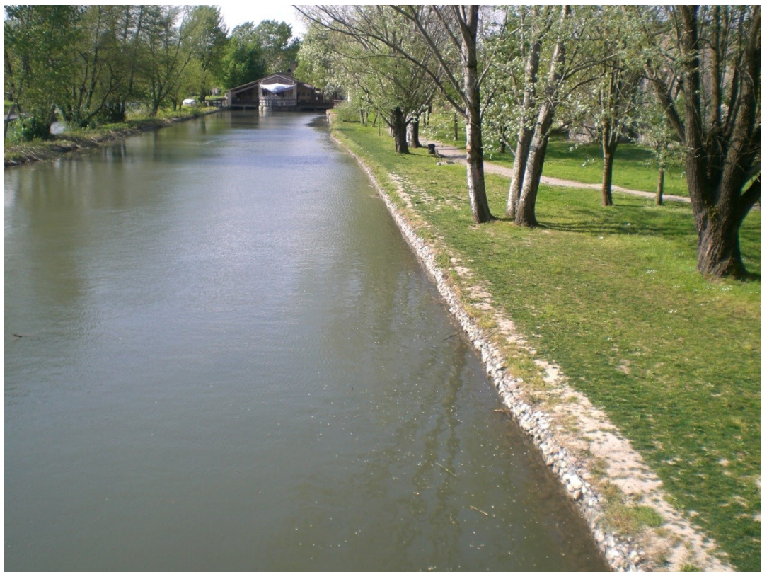
Figura 10: vista di una gabbionata a sostegno della sponda nelle immediate vicinanze del ponte di Goito
