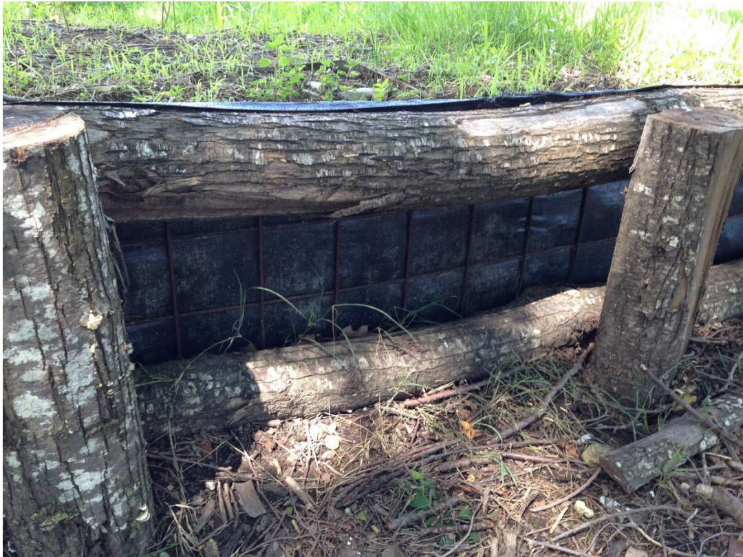
Figura 9: sistemazione di palificata a sostegno di un piccolo argine in località Presa Moschini
