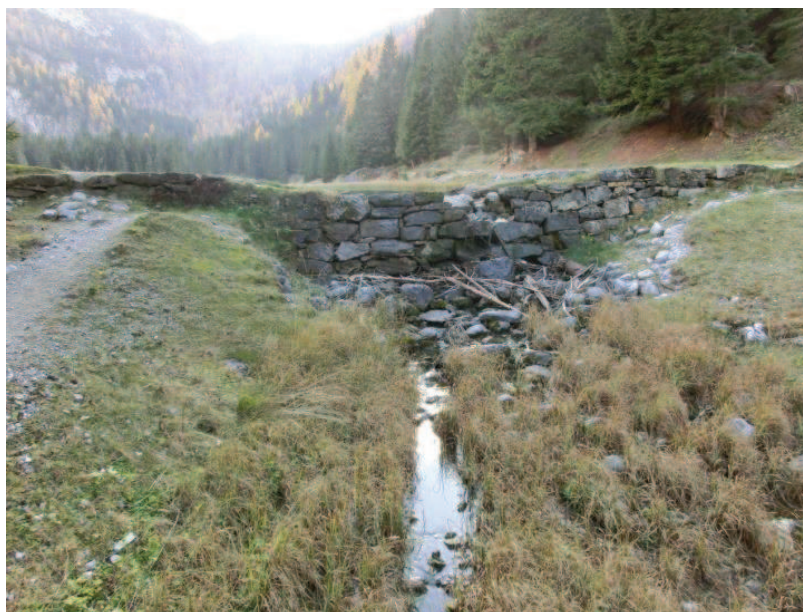
Fig. 12: Soglia di sbarramento in pietrame e gabbionate degli anni '70 ed emissario.
