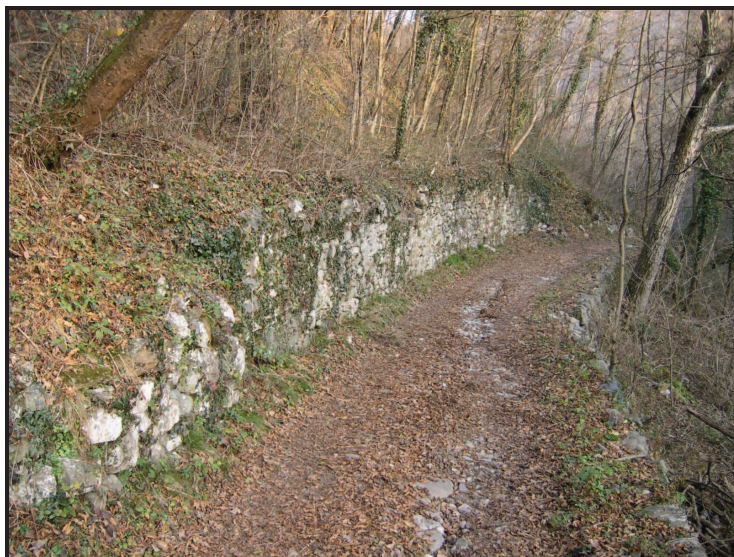
figura 5.2 - Muro di controripa in sasso
