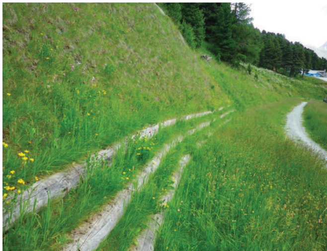
Figura 1.6 Inerbimento di una sponda di contenimento con materiale autoctono – St. Moritz (Svizzera).
