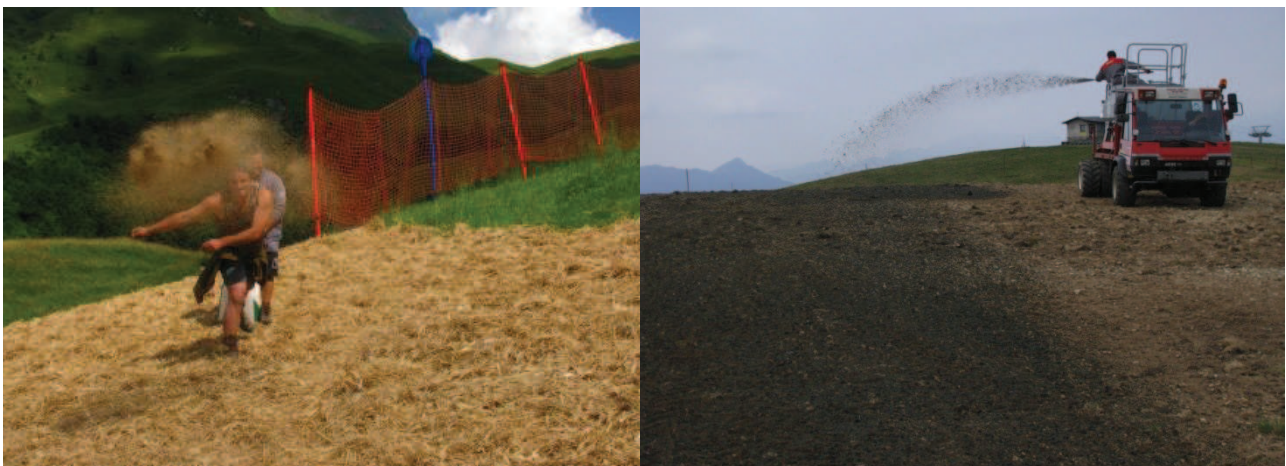
Figura 1.8 (A) Semina a spaglio con copertura di paglia. (B) Inerbimento con la tecnica dell'idrosemina.
