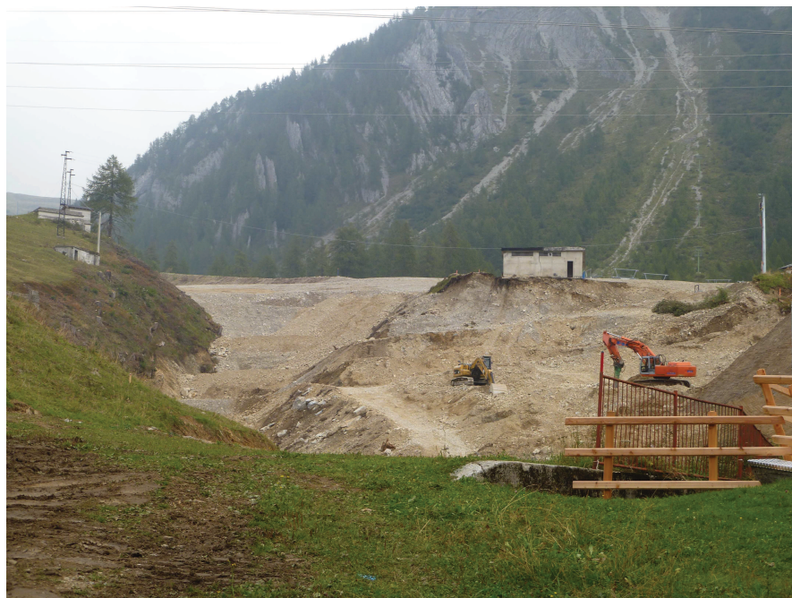
Lavori di costruzione per una nuova pista da sci
