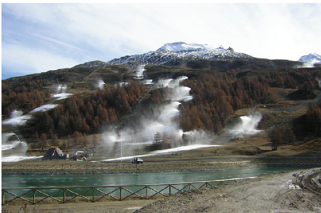
Snowmaker in azione con acqua prelevata dalla riserva idrica artificiale
