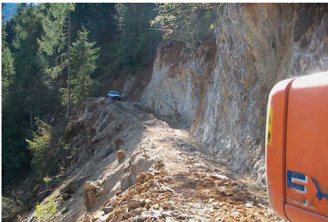
Figura n. 31 : strada agro-silvo-pastorale Campelli-San Salvatore in fase di realizzazione.
