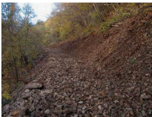
Figura n. 68 e 69: strada agro-silvo-pastorale Gandola-Romeri-Paganoni, lavori di rifinitura delle scarpate, realizzazione (strato di fondazione 15-25 cm in pietrisco locale) e sagomatura della sede stradale.
