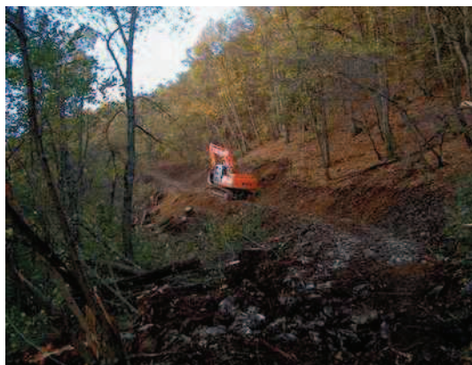
Figura n. 66 e 67: strada agro-silvo-pastorale Gandola-Romeri-Paganoni, lavori di rifinitura delle scarpate, realizzazione e sagomatura della sede stradale.
