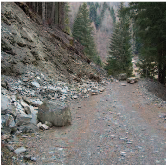
Figura n. 76 e 77: strada agro-silvo-pastorale Capelli-Meriggio-San Salvatore, franamenti della scarpata di monte sulla sulla carreggiata.
