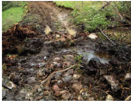
Figura n. 64 e 65: strada agro-silvo-pastorale Gandola-Romeri-Paganoni, realizzazione della traccia di scavo.
