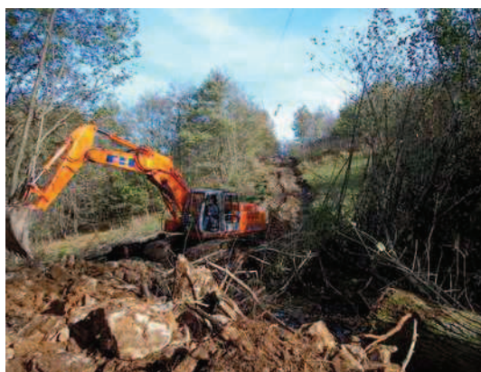
Figura n. 68 e 69: strada agro-silvo-pastorale Gandola-Romeri-Paganoni, lavori di rifinitura delle scarpate, realizzazione (strato di fondazione 15-25 cm in pietrisco locale) e sagomatura della sede stradale.
