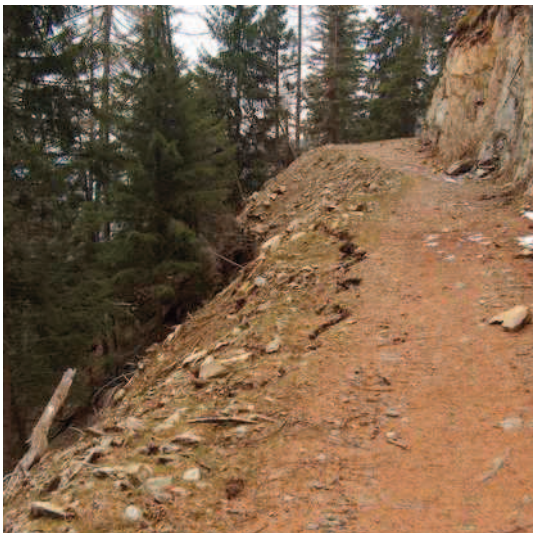
Figura n. 74 e 75: strada agro-silvo-pastorale Capelli-Meriggio-San Salvatore, segni di cedimento scarpata di valle e franamento sulla sulla carreggiata.
