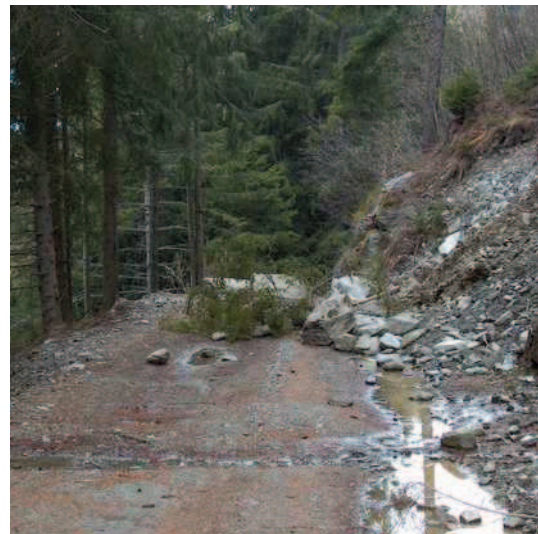
Figura n. 74 e 75: strada agro-silvo-pastorale Capelli-Meriggio-San Salvatore, segni di cedimento scarpata di valle e franamento sulla sulla carreggiata.
