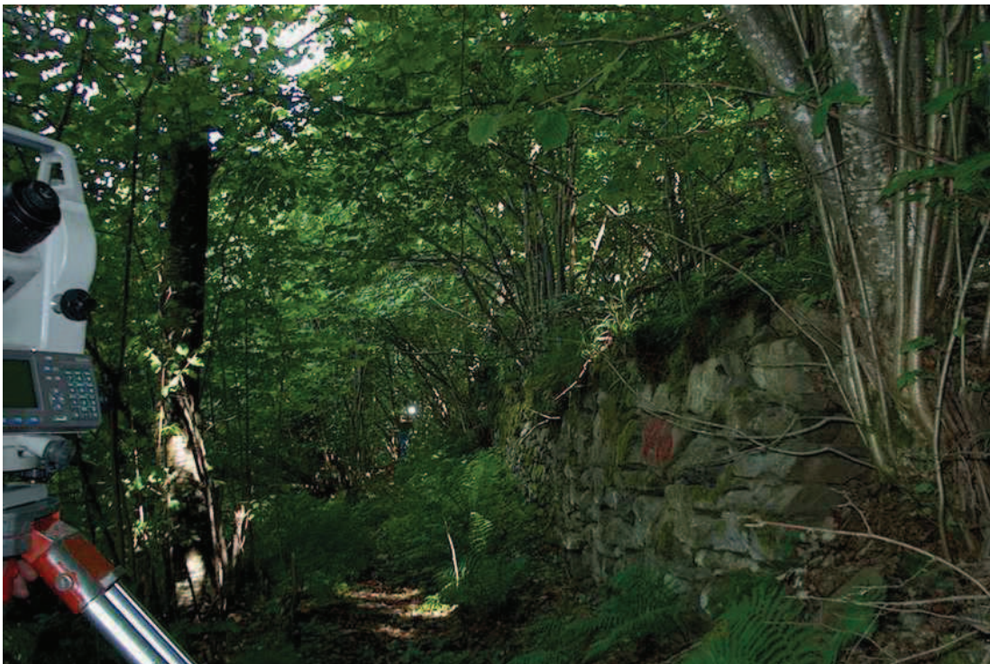
Figura n. 18: strada agro-silvo-pastorale Gandola-Romeri-Paganoni in comune di Albosaggia, fasi di rilievo strumentale.
