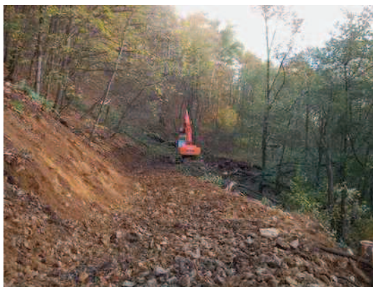
Figura n. 66 e 67: strada agro-silvo-pastorale Gandola-Romeri-Paganoni, lavori di rifinitura delle scarpate, realizzazione e sagomatura della sede stradale.
