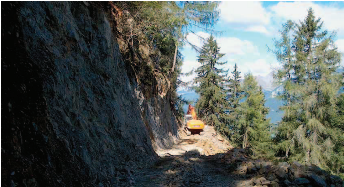
Figura n. 70 e 71: strada agro-silvo-pastorale Capelli-Meriggio-San Salvatore, lavori di realizzazione tratti con scavo in roccia .
