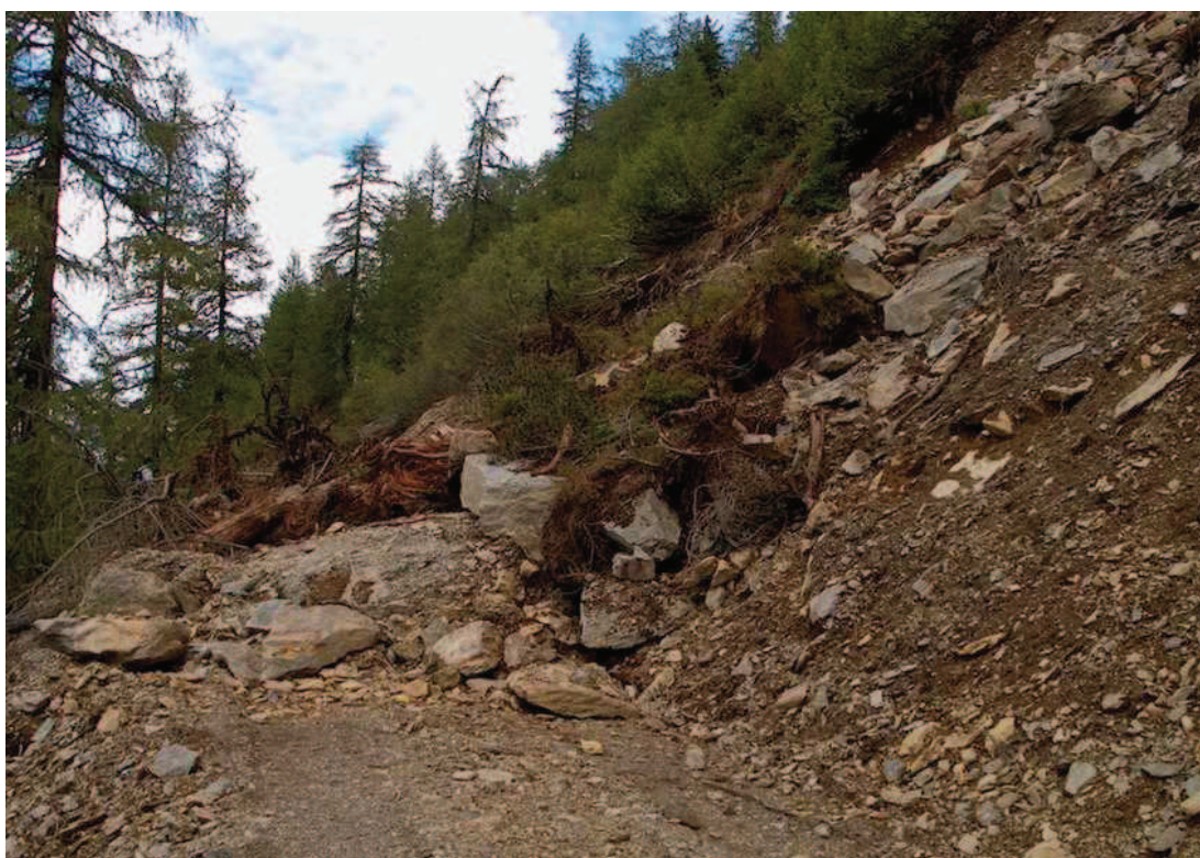
Figura n. 13: viabilità agro-silvo-pastorale Campelli-Meriggio-San Salvatore , franamento della scarpata di monte (2001).
