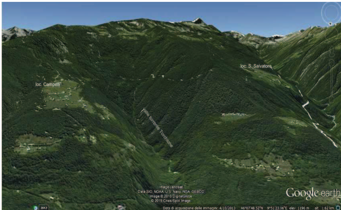
Figura n. 27: vista generale della strada agro-silvo-pastorale Campelli-San Salvatore. Immagini tratte da Google earth per fini non commerciali e dunque non soggetti a preventiva autorizzazione secondo i Termini di servizio di Google Inc.
