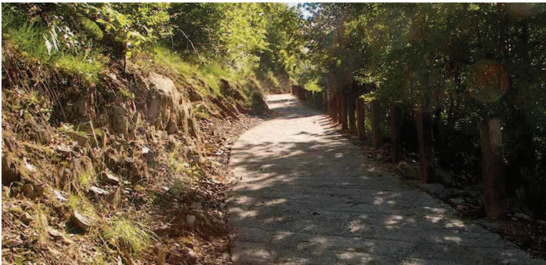
Figura n. 60: strada agro-silvo-pastorale Gandola-Romeri-Paganoni, lavori ultimati di pavimentazione con battuto di cemento armato e posa di parapetto protettivo in legno di rovere.
