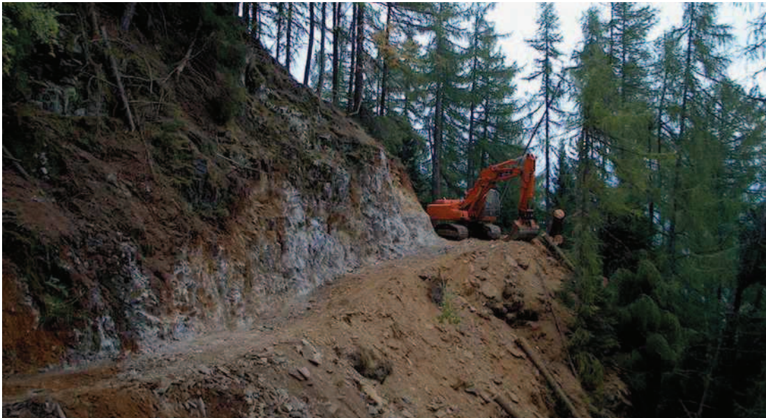
Figura n. 70 e 71: strada agro-silvo-pastorale Capelli-Meriggio-San Salvatore, lavori di realizzazione tratti con scavo in roccia .
