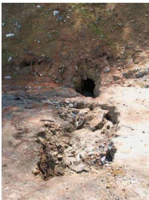
Figura n. 43: strada a.s.p. Campelli-Meriggio-San Salvatore, punto di fuoriuscita del deflusso sottosuperficiale
