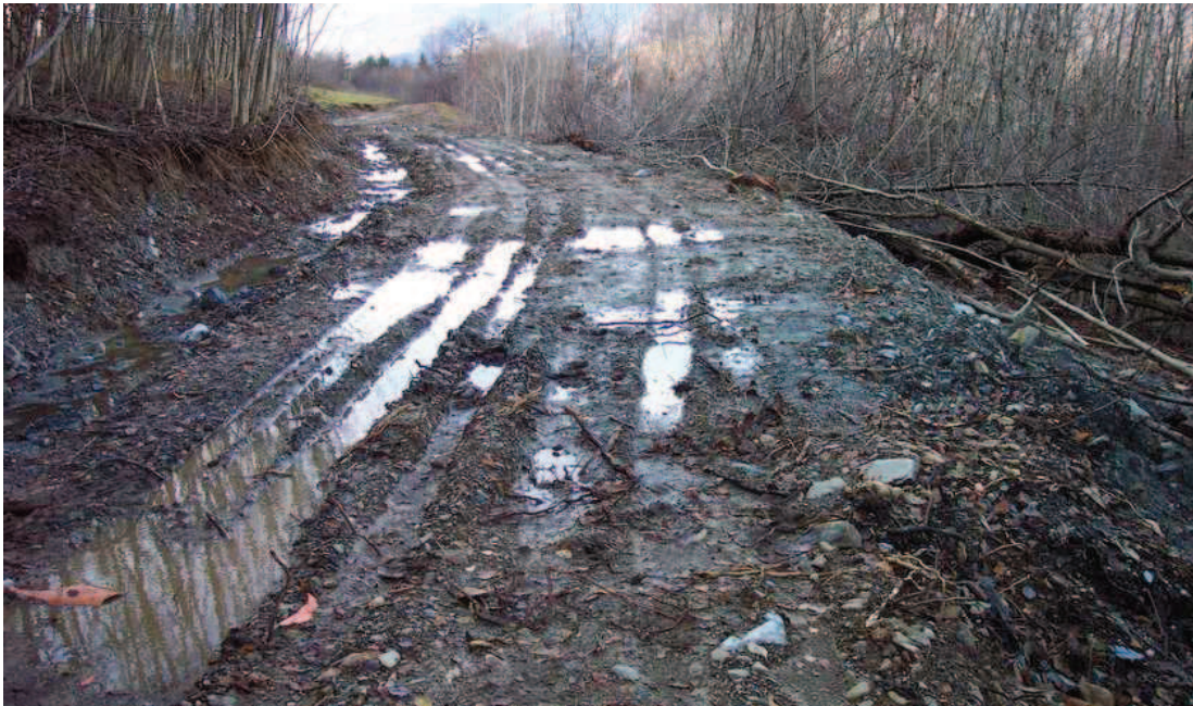
Figura n. 51 e 52: strada agro-silvo-pastorale Gandola-Romeri-Paganoni, fenomeni di ristagno idrico.
