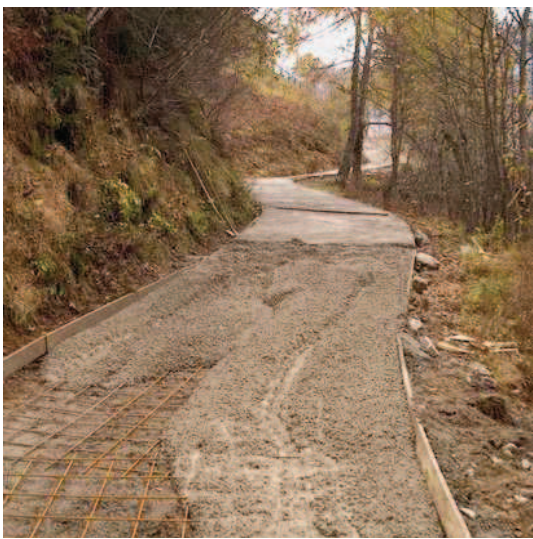
Figura n. 56, 57, 58 e 59: strada agro-silvo-pastorale Campelli-Meriggio-San Salvatore, lavori di pavimentazione con battuto di cemento armato con rete elettrosaldata.
