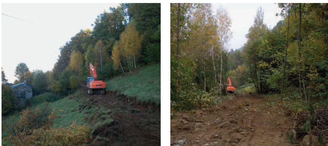
Figura n. 61 e 62: strada agro-silvo-pastorale Gandola-Romeri-Paganoni, realizzazione della traccia di scavo.
