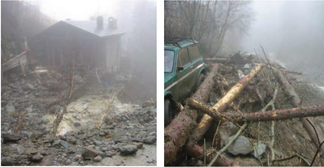
Figura n. 4 e 5: località San Salvatore in comune di Albosaggia (SO), alluvione 2002.
