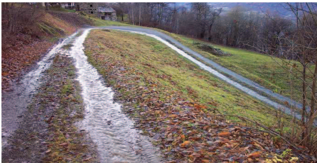
Figura n. 47 e 48: strada agro-silvo-pastorale Gandola-Romeri-Paganoni, incanalamento del deflusso sulla sede stradale.
