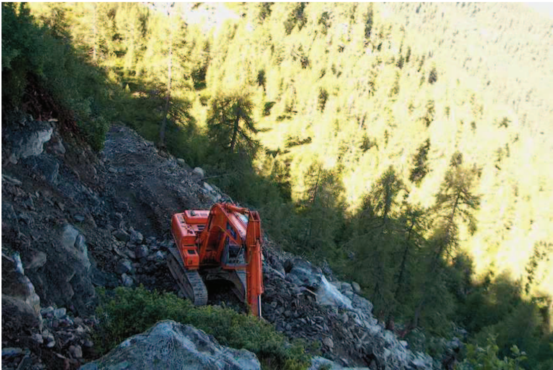
Figura n. 45 e 46: strada agro-silvo-pastorale Campelli-Meriggio-San Salvatore, franamento della scarpata di monte e i relativi lavori di ripristino della viabilità.
