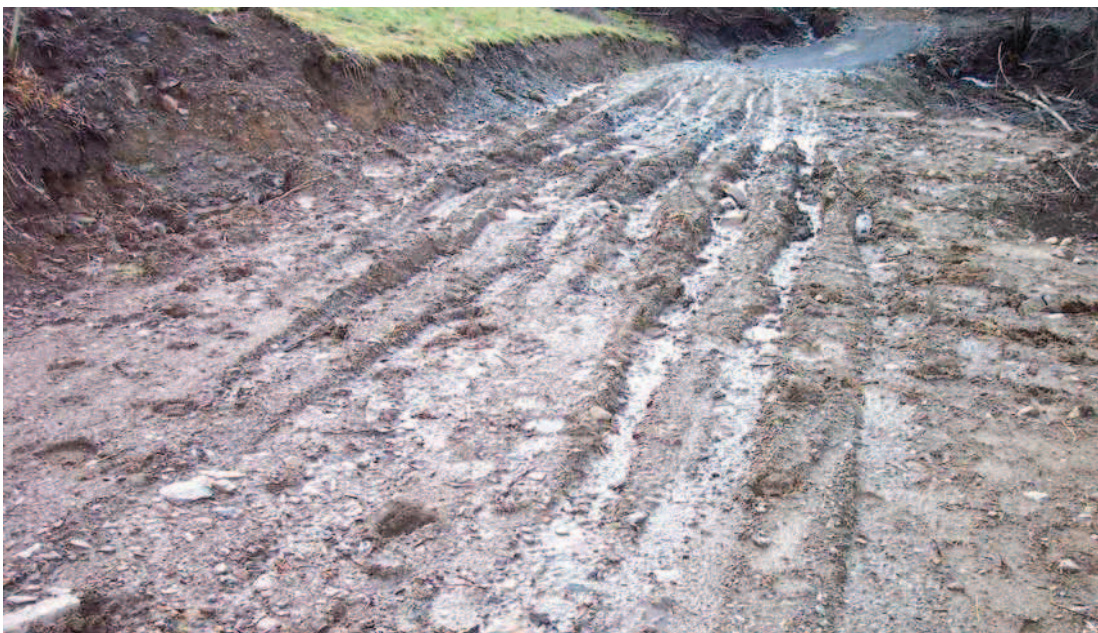
Figura n. 51 e 52: strada agro-silvo-pastorale Gandola-Romeri-Paganoni, fenomeni di ristagno idrico.
