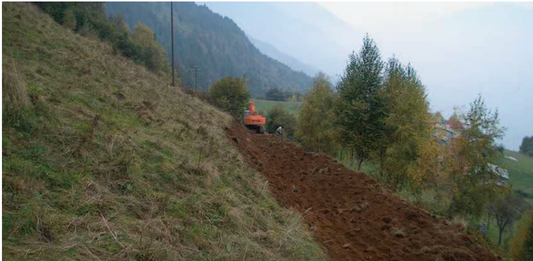
Figura n. 63: strada agro-silvo-pastorale Gandola-Romeri-Paganoni, durante i lavori. Sullo sfondo, a destra, la località Paganoni.
