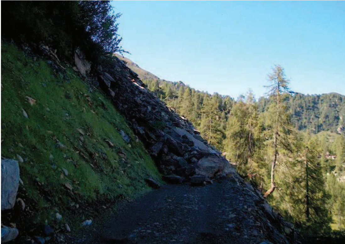
Figura n. 45 e 46: strada agro-silvo-pastorale Campelli-Meriggio-San Salvatore, franamento della scarpata di monte e i relativi lavori di ripristino della viabilità.
