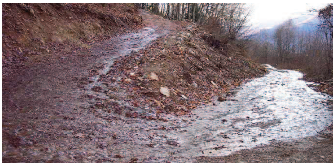
Figura n. 47 e 48: strada agro-silvo-pastorale Gandola-Romeri-Paganoni, incanalamento del deflusso sulla sede stradale.
