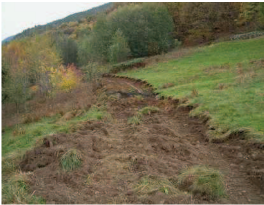
Figura n. 64 e 65: strada agro-silvo-pastorale Gandola-Romeri-Paganoni, realizzazione della traccia di scavo.
