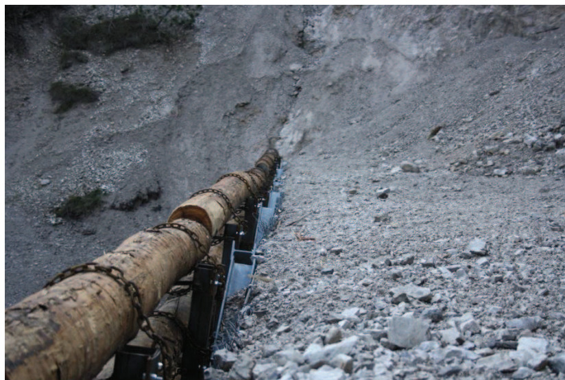
Figura 72. Fila di pannelli con un'eccessiva quantità di materiale di riempimento.
