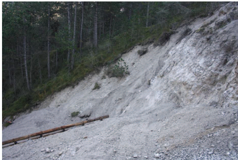
Figura 76. Porzione di versante, sulla destra orografica del torrente Bertone, con intensi fenomeni di erosione superficiale.
