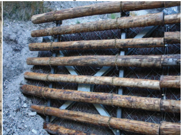
Figura 65. Pannello Erdox completamente rivestito con i pali in larice.
