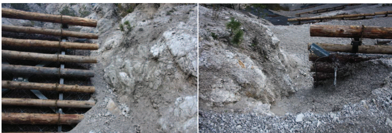
Figura 67 e 68. Franamenti di materiale ai lati della fila di pannelli consolidatori.
