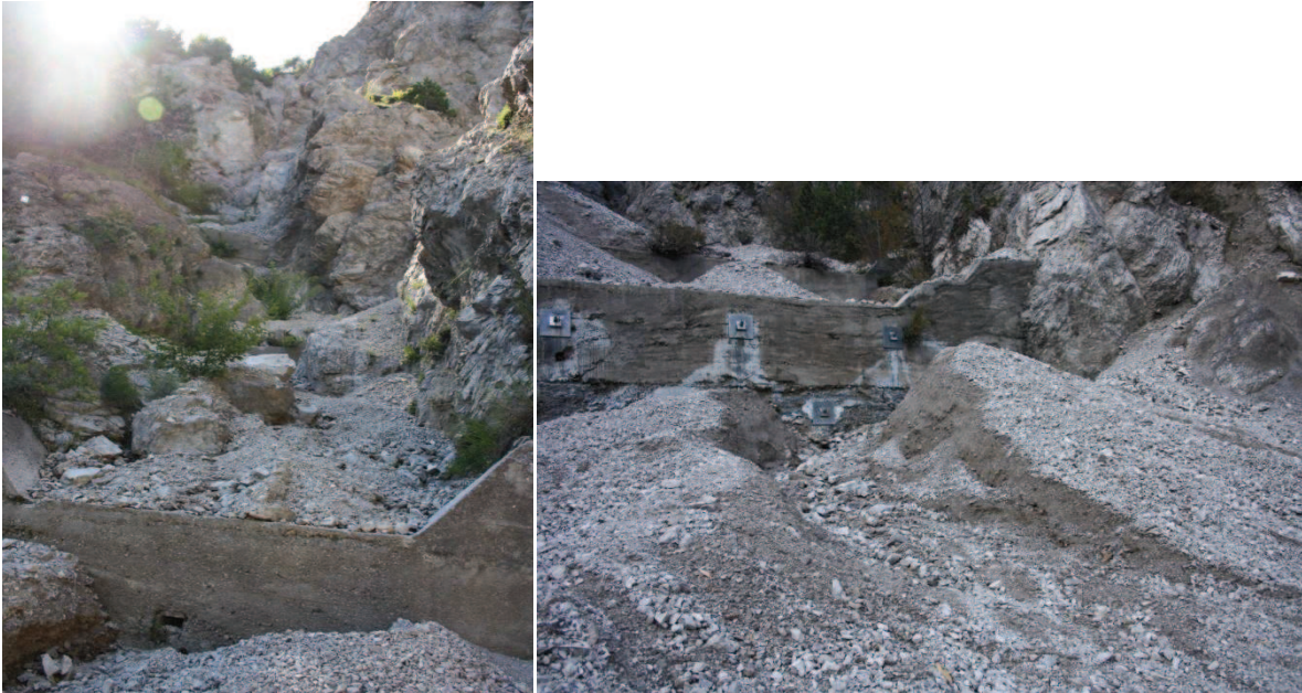
Figure 13 e 14. Tratto del torrente Bertone sottoposto a sistemazione mediante briglie chiuse, realizzate dal CFS negli anni '60 che, fino a prima dell'attuale intervento di sistemazione, risultavano eccessivamente sovra-alluvionate.
