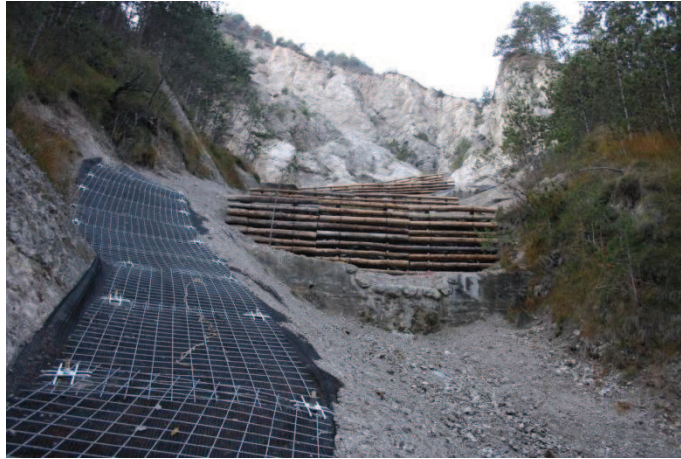
Figura 59. Rivestimento antiersivo sulla destra orografica del Torrente Bertone.
