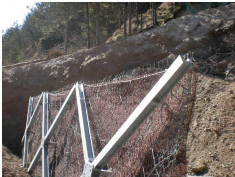
Fase 2 : Posizionamento dei pannelli e loro ancoraggio ai tiranti.
