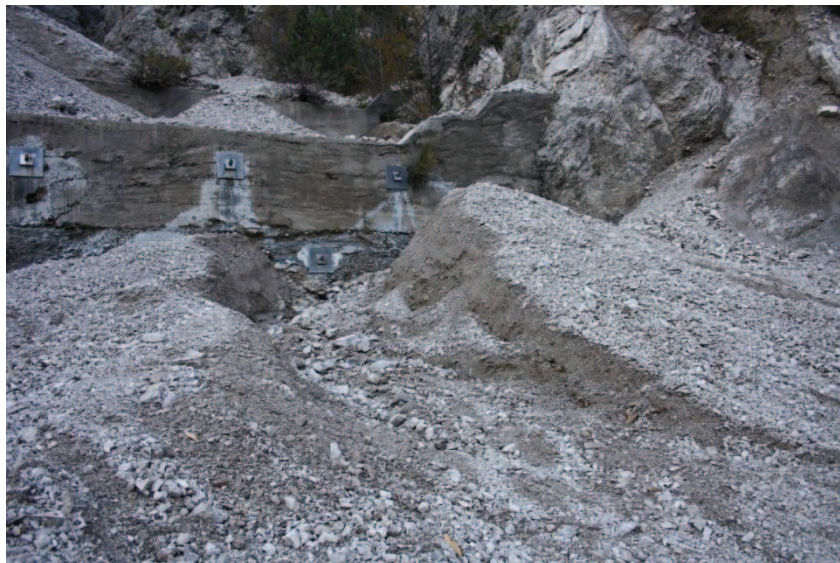
Figura 74. Quantità di materiale che sovra alluviona la briglia.
