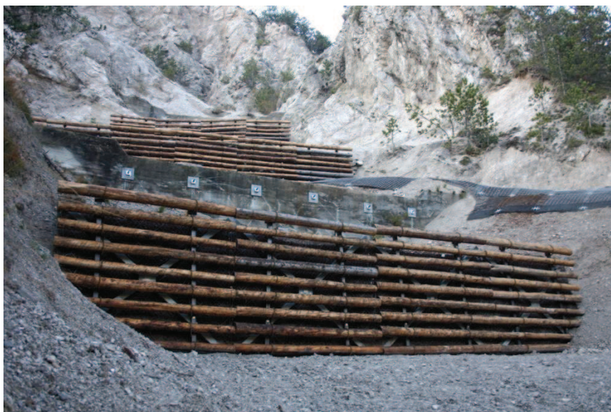
Figura 66. Visione d'insieme dei pannelli Erdox rivestiti con i pali in larice.
