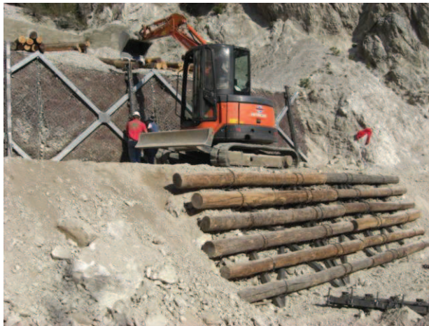
Figura 64. Montaggio dei tubolari in acciaio lungo l'intera barriera di pannelli.
