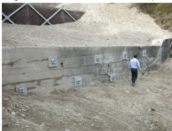
Figura 51. Briglia in Cls con chiodature di consolidamento in Val Bertone.
