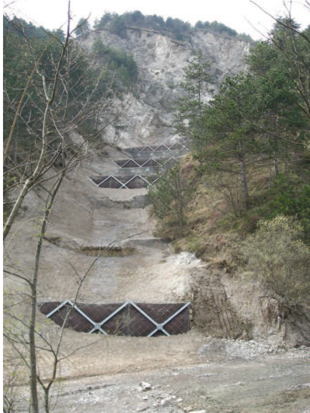
Figura 52. Sistemazione con profilo a gradonata in Val Bertone.
