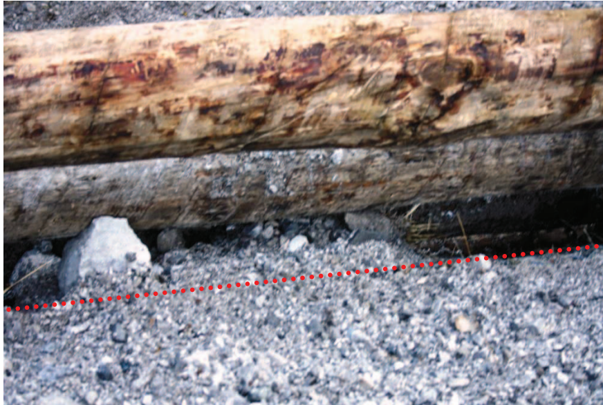
Figura 73. In rosso è evidenziato il filo esterno del pannello che è stato superato dal materiale di riempimento che perciò è andato ad occupare l'intercapedine tra il pannello Erdox ed i pali di larice.
