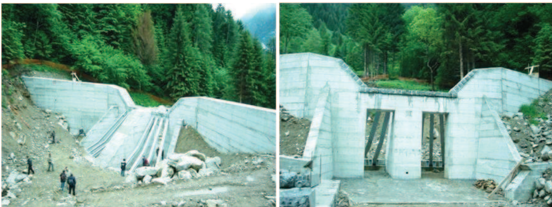
Figure 18 e 19. Esempio di briglia filtrante con particolare propensione alla laminazione di un Debris Flow. Autore: Quaderni della Ricerca della Regione Lombardia n. 116- giugno 2010.
