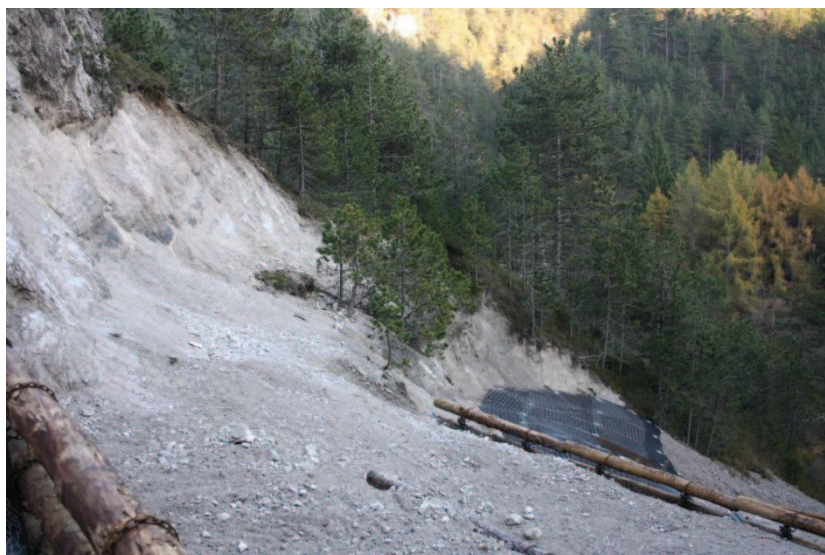
Figura 77. Porzione di versante, sulla sinistra orografica del torrente Bertone, con intensi fenomeni di erosione superficiale.
