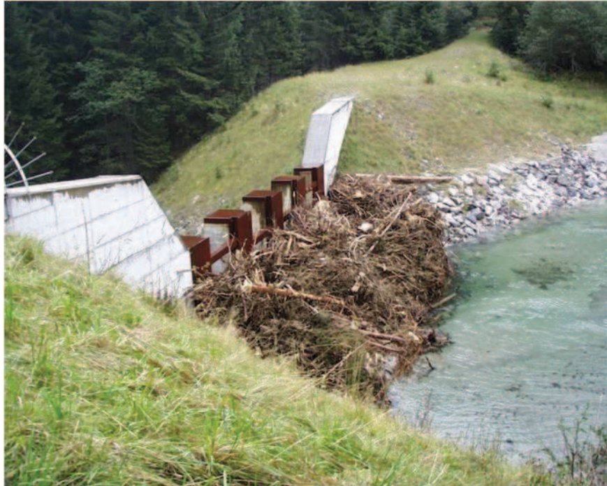
Figura 17. Materiale fluitato trattenuto da una briglia selettiva. Autore: Quaderni della Ricerca della Regione Lombardia n. 116- giugno 2010.
