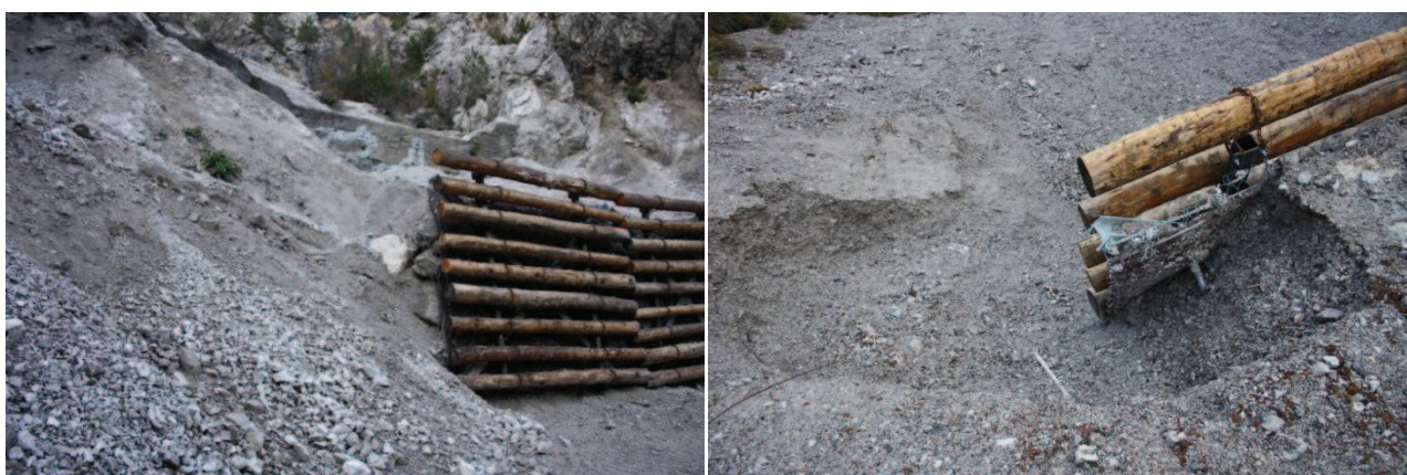
Figura 69 e 70. Franamenti di materiale ai lati della fila di pannelli consolidatori.
