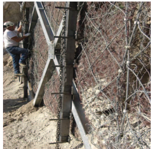
Figura 63. Posizionamento e fissaggio dei tubolari in acciaio per il sostegno dei pali in larice.
