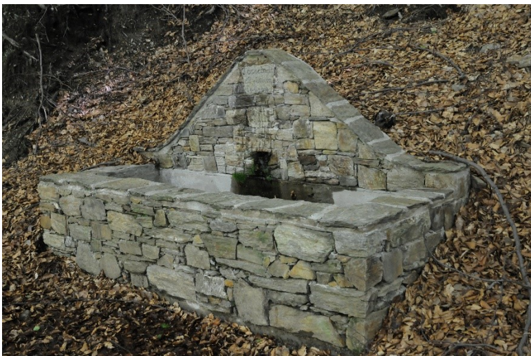
Fontana sulla strada per l'Alpe di Rozzo
