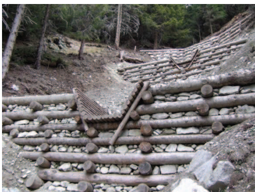
Foto 6, intervento di sistemazione idraulico forestale. Intervento di ingegneria naturalistica per il consolidamento dei versanti, foto 7, Consorzio Forestale Due Parchi.
