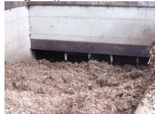
Foto 11, silo di stoccaggio cippato. Foto 12, sistema a spintori per la movimentazione automatica del cippato.
