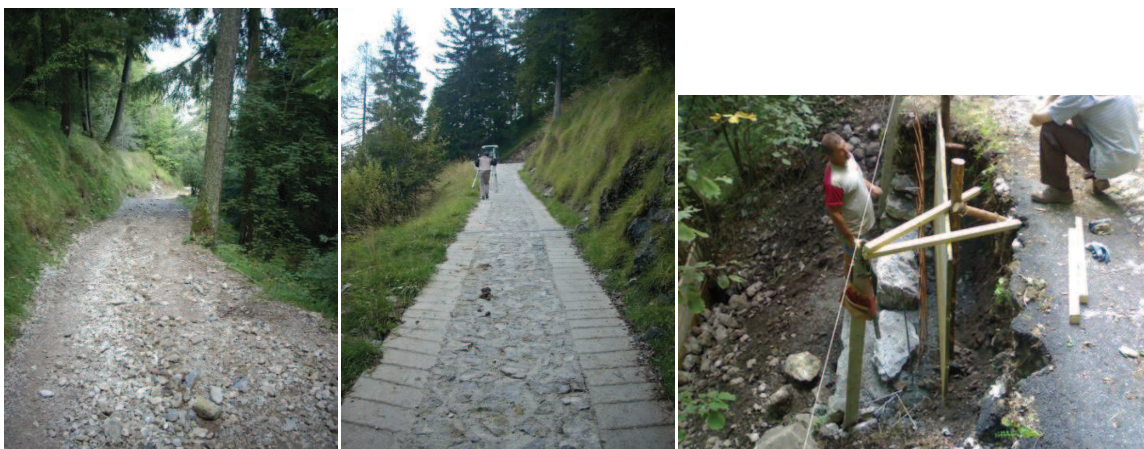
Foto 3, intervento n.1. Situazione del fondo stradale prima dei lavori di pavimentazione. Foto n. 4, tipologia di pavimentazione presente a valle della zona di intervento. Foto n. 5, intervento n. 2.
