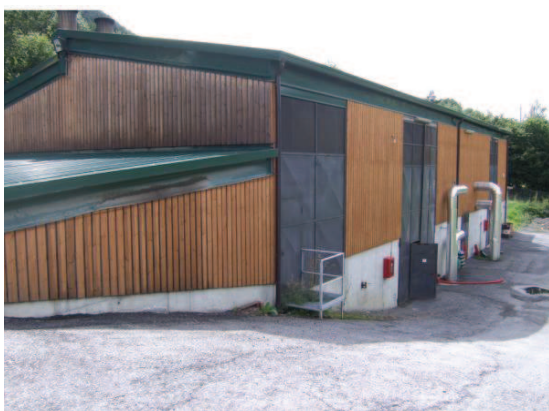
Foto 7, centrale termica di Temù.
