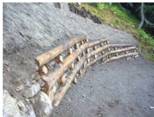
Foto 6, intervento di sistemazione idraulico forestale. Intervento di ingegneria naturalistica per il consolidamento dei versanti, foto 7, Consorzio Forestale Due Parchi.
