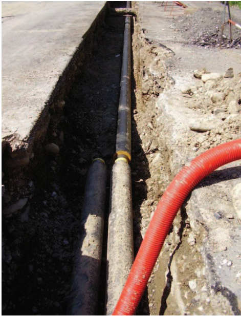
Foto 19, rete di condutture interrate in poliuretano espanso con rivestimento in politene. Foto 20, particolare della griglia mobile inclinata.
