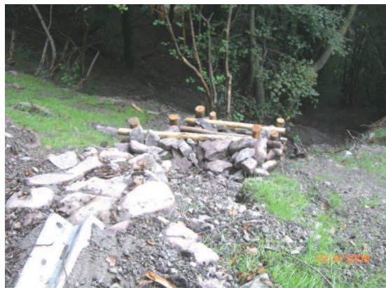
Foto 14, canalette trasversali per agevolare il deflusso idrico e palificate per il sostegno del versante.
