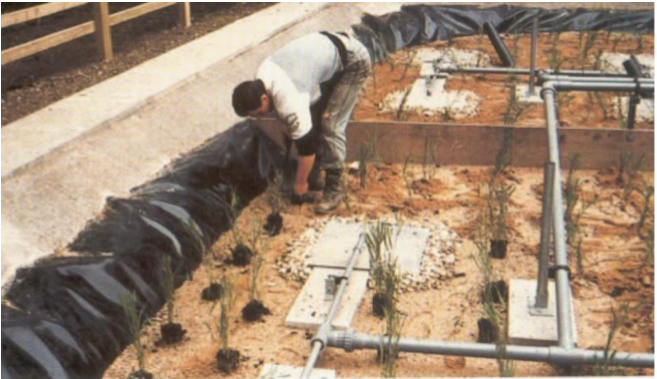
Figura 17: Messa a dimora delle macrofite in un impianto sub-superficiale verticale. (fonte: Cooper et al.,1996)
