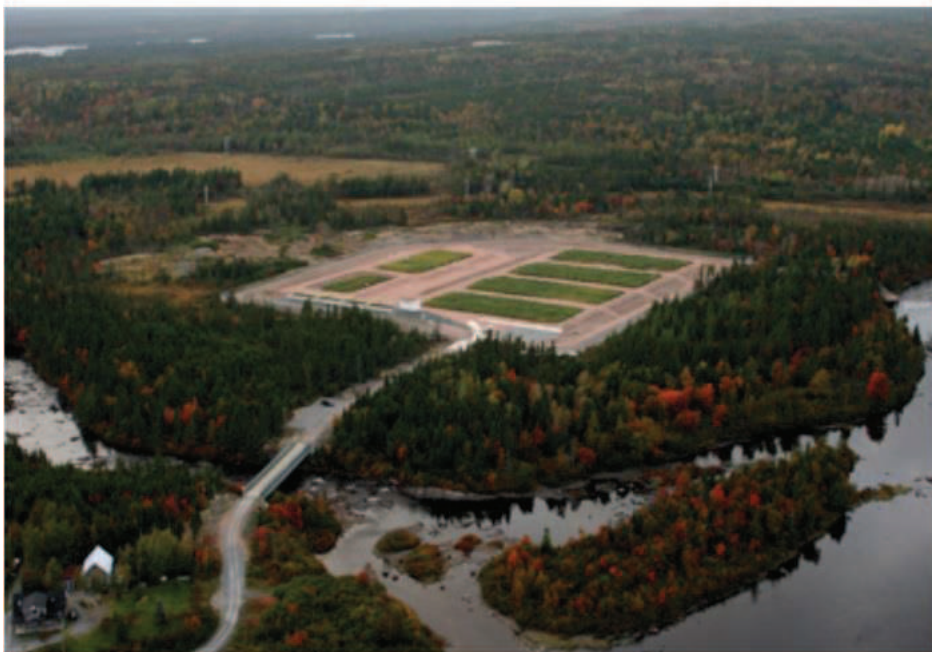
Figura 38: Impianto di fitodepurazione a flusso sommerso realizzato in Canada, con una capacità di 1800 abitanti equivalenti (fonte: abydoz.com )
