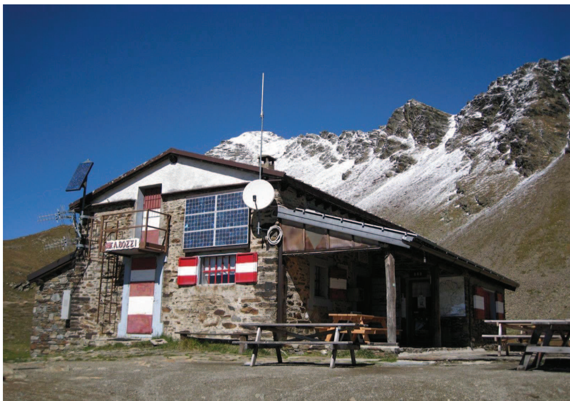
Figura 4: Esempio di struttura classificata come rifugio: Rifugio Bozzi, alta Val di Viso (Bs). (fonte: cai.bs.it)
