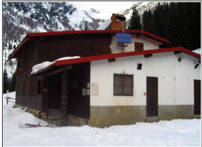
Figura 4: Il rifugio CAI Alpe Corte Bassa è un ottima struttura da adibire a ristoro (CABINI - 2006)
