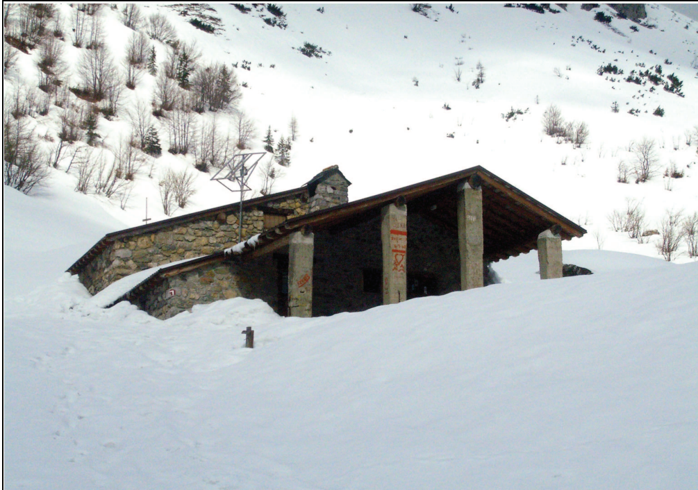
Figura 55: In inverno le abbondanti nevicate coprono quasi completamente le Baite Neel, rendendole inaccessibili (CABINI - 2006)
