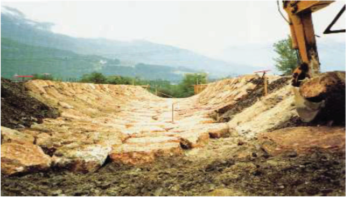
Figura 17: esempio di cunettone (Bischetti ,2006).
