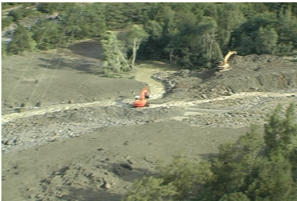
Figura43: sbarramento sul corso del fiume Oglio.
