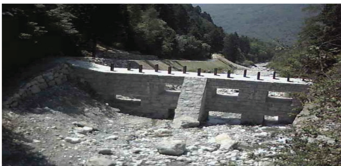
Figura 52: briglia selettiva, presenta una tipologia di filtro a finestre, con presenza di pettini posizionati sull'estremità superiore.
