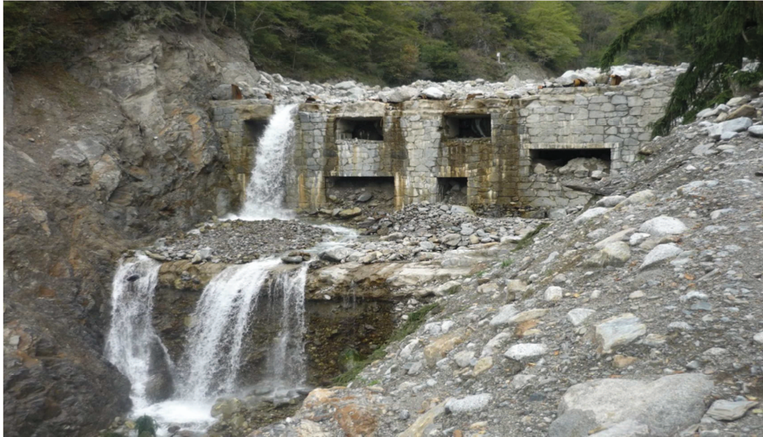
Figura 54: briglia selettiva in seguito al passaggio della colata detritica del 27 luglio 2012.
