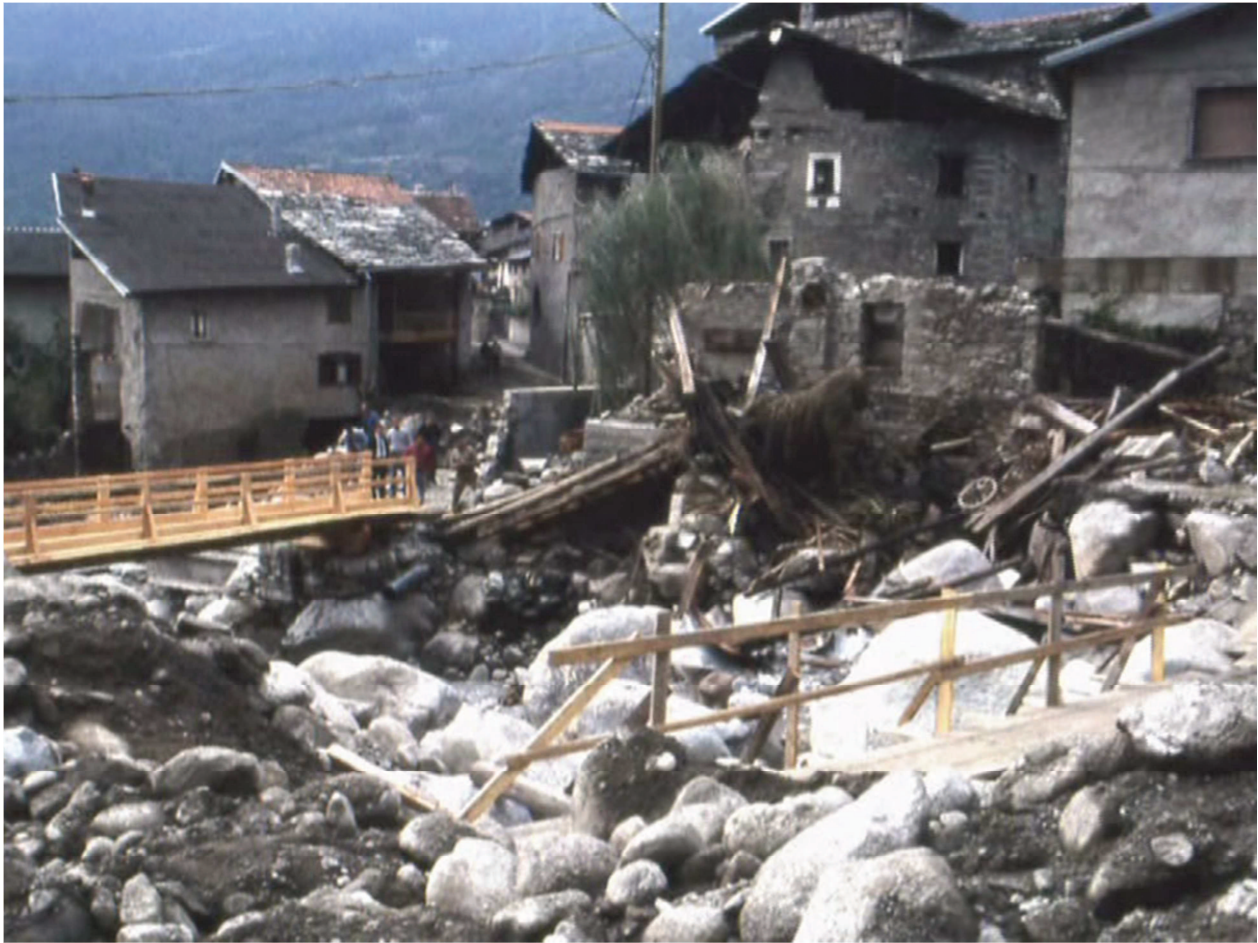
Figura 59: immagine che documenta i danni provocati all'abitato di Rino dalla colata detritica provocata dal Torrente Remulo nel settembre 1987.
