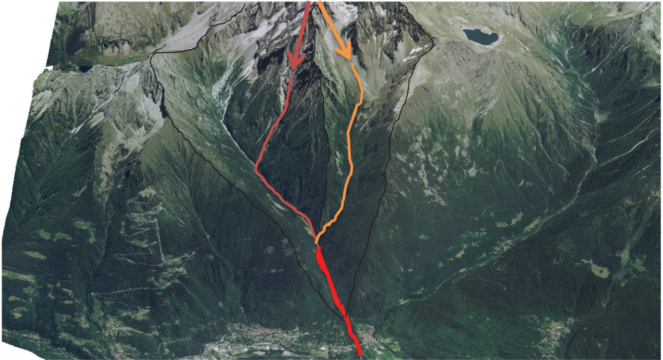
Figura 34 : ortofoto 3D in cui si evidenzia la zona d'innescò delle colate. La freccia rossa indica il punto d'innescò della colata nella testata di Gallinera, mentre la freccia arancione indica il punto d'innescò nella testata di Bompiano.
