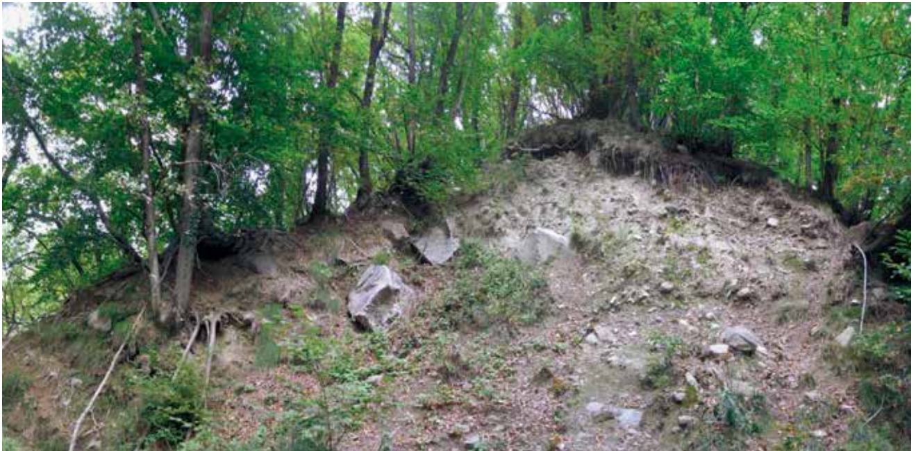
Figura 12. Corona di frana in fase di arretramento nell'intorno del ribaltamento.
