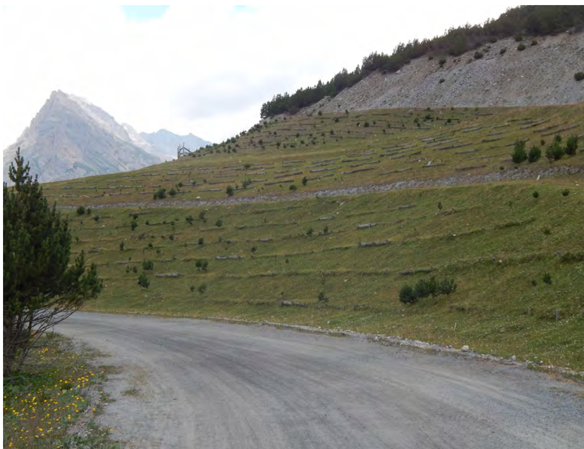
Figura 1: Area di studio - rinverdimento su strato di smarino (anno 2015).
