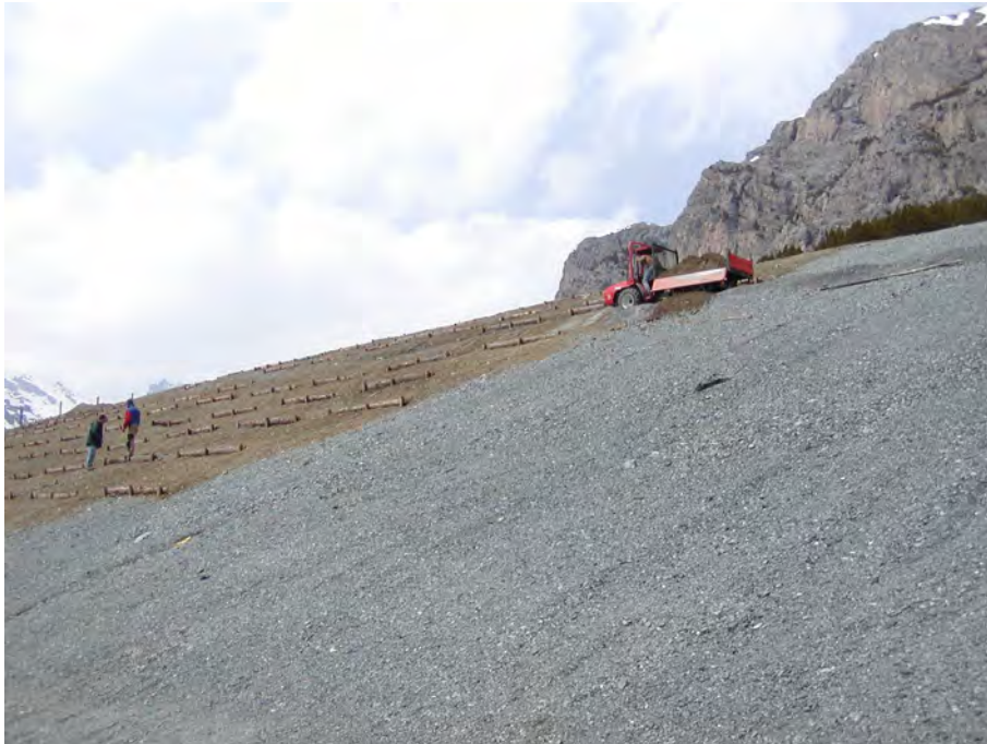
Figura 24: Copertura dello smarino con terreno vegetale fertile.
