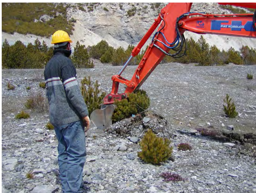
Figura 22: Operazione di impianto.
