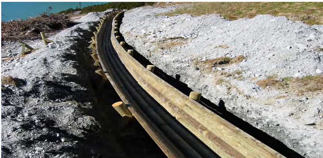
Figura 25: Canalizzazioni per la regimazione delle acque.
