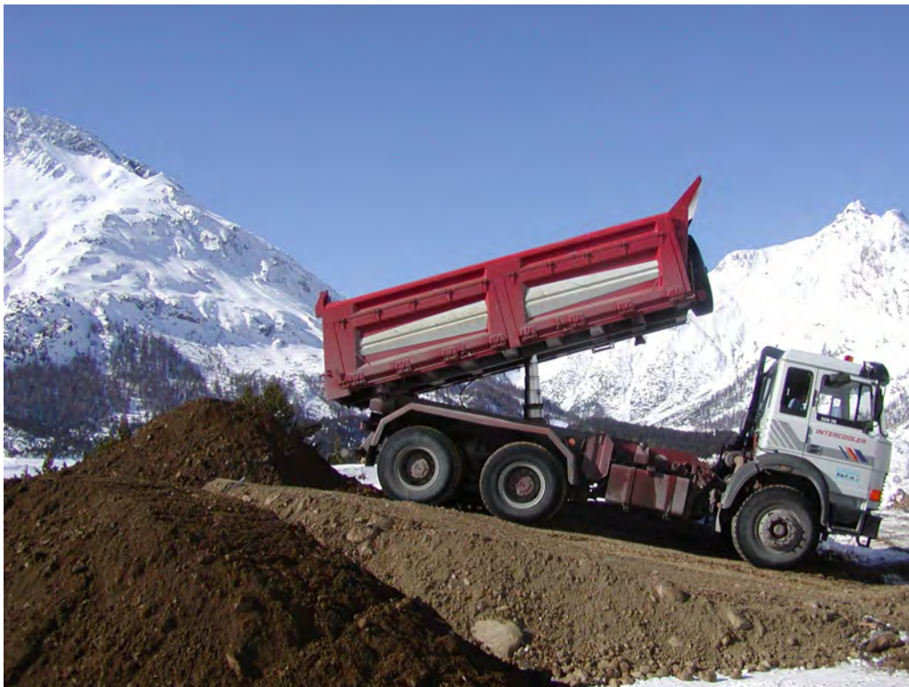
Figura 15: Inizio lavori di rimodellamento del versante.
